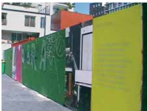
Baustelle einer Wohnüberbauung.
